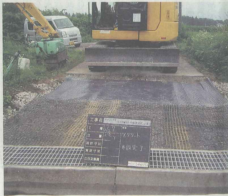
凍上抑制対策として試験施工
