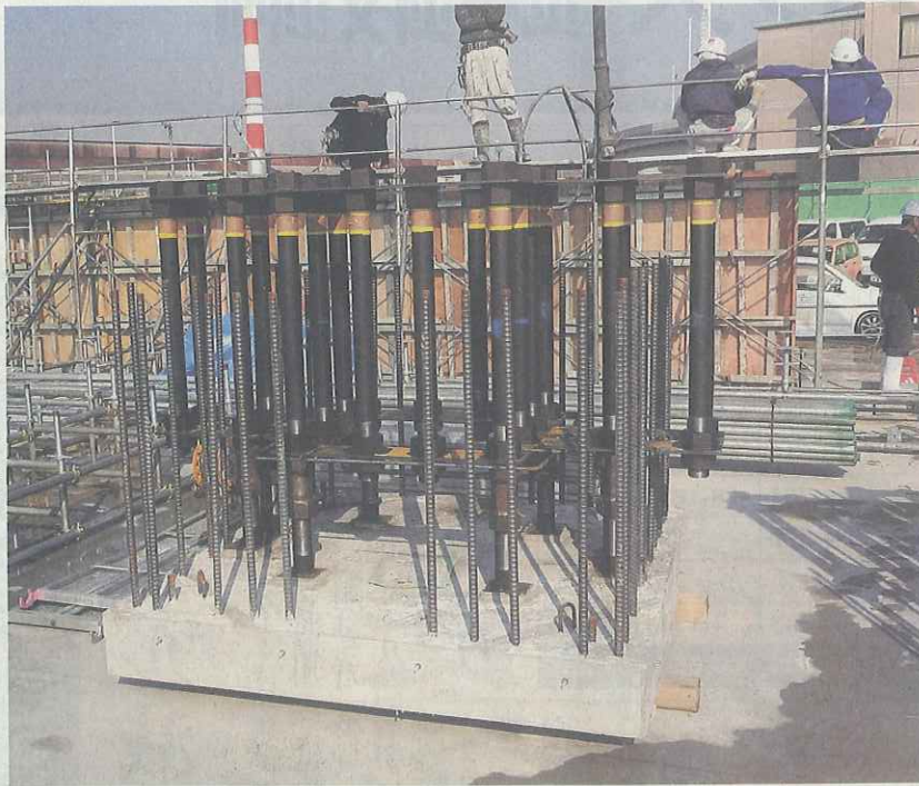
Dスルー工法の施工状況
