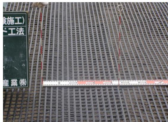
※材料の大きさは横 3.9m×縦 100m、したがって縦は 100m 敷設後重ね合わせ。
