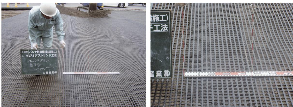
※材料の大きさは横3.9m×縦100m、したがって縦は100m敷設後重ね合わせ。
